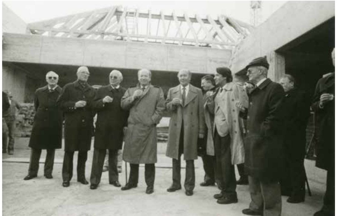
Kammeranbau an der Königstraße, hier das Richtfest mit Präsident Alfred Padberg und Hauptgeschäftsführer Wilfrid Maul am 2. Dezember 1983 (WWA, K 6 Nr. 970).
