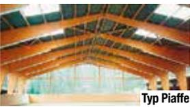
**Hallenkonstruktion mit Holzleimbinder F-30B**
